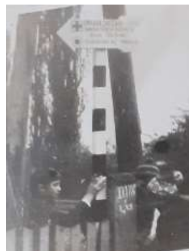
Fixarea indicatorului de intrare pe Drumul Vitoriei Lipan
