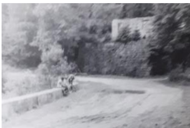
Ziduri din piatră pe drumul de pe Stânișoara și ruinele cantonului Bașa.
